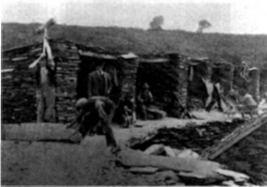
Zurichten der Schieferblöcke. Preselau Quarry, Dyfed, 1920er Jahre
