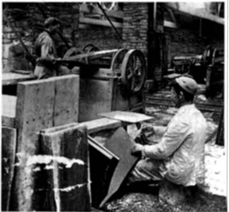
Spalten des Schiefers und Arbeit mit einer rotierenden Zurichtmaschine von J.W. Greenes, Llanwnda Quarry, Ende des 19. Jahrhunderts – Gwynedd Archives
