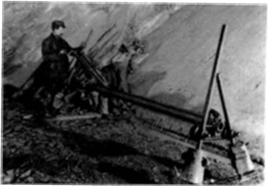
Trennarbeit mit einem Preßluftbohrer. Oakeley Quarry, Ffestiniog, Ende des 19. Jahrhunderts – Gwynedd Archives
