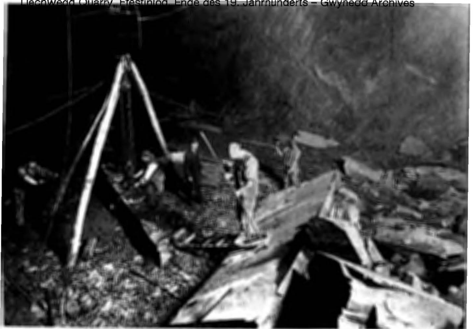
Heraustrennen eines Schieferblocks mit einer Bohrstange und Förderung mit einem Haspel. Llechwedd Quarry, Ffestiniog, Ende des 19. Jahrhunderts – Gwynedd Archives
